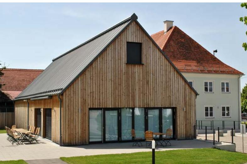
Einerseits fügt sich der Pfarrstadel durch seinen langgestreckten Baukörper mit dem typischen Steildach harmonisch in die regionale Hauslandschaft ein. Andererseits steht er aufgrund der Verwendung von Stahl als Tragkonstruktion, heimischem Lärchenholz als Außenschalung und Blech als Dachdeckung für zeitgemäßes Bauen.
